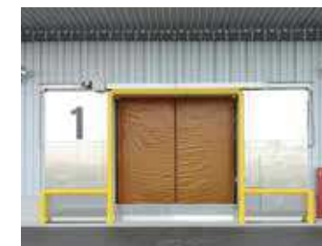
ステンレス製断熱扉 +ライスガード(手動)
